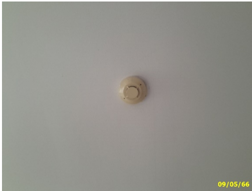
เครื่องตรวจจับความร้อน (Heat Detector)
