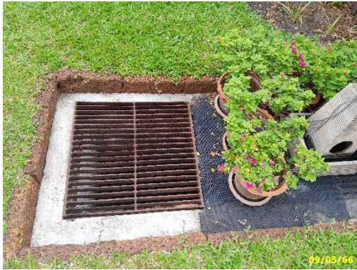
บ่อกักน้ำก่อนระบายออกสู่ท่อระบายน้ำ สาธารณะ
