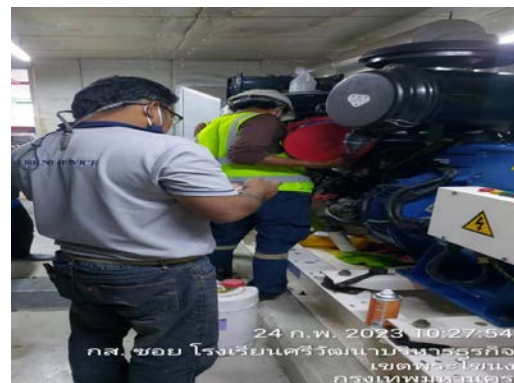
ตรวจเช็คระบบไฟฟ้าสำรอง
